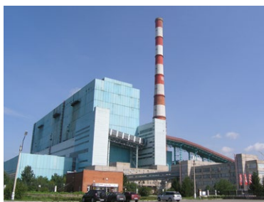
Березовская ГРЭС, г. Шарыпово, Красноярский край
